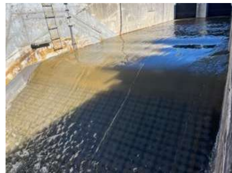
写真-5 越水実験 (越水時)
