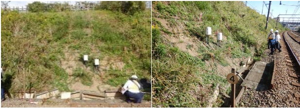
写真-4 システム設置状況
