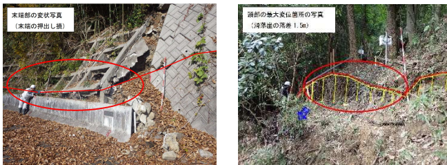
写真-5 被災法面断面状況
