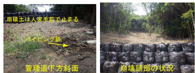
写真-1 東側崩壊斜面の状況
