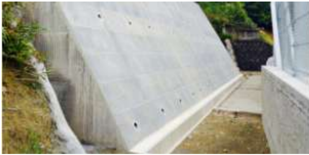
図-4 擁壁への打入ドレン（簡易水抜き管）設置状況 4)
