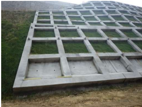
写真-7 吹付法枠とアンカー
