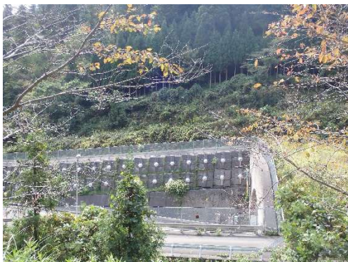
写真-8 プレキャスト受圧板とアンカー
