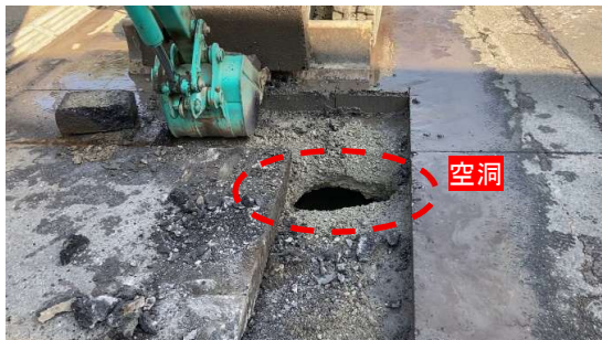
図-1 路面直下に出現した空洞の例
