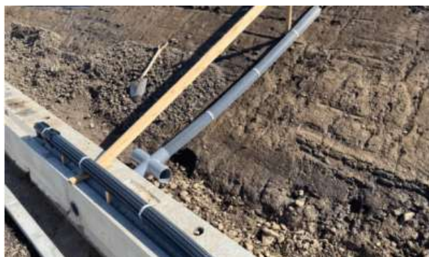
図-8 暗渠排水管の設置状況 8)
