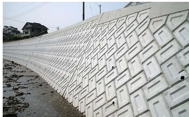
図-6 河川堤防の水抜き孔設置状況 6)
