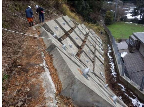
写真-10 RC 独立受圧板とアンカー
