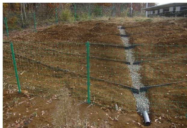
図-10 スロープ・ドレンの設置状況 10)
