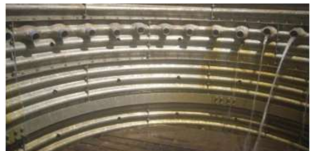
集水井から井戸への地下水排水状況
