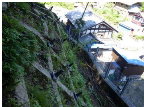
写真-11 吹付法枠とアンカー
